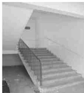
图 11 位于结构端部的 楼梯间震后图片 (彭州市小鱼洞九年制学校)
