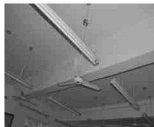
图10 楼面预制预应力板无裂缝
