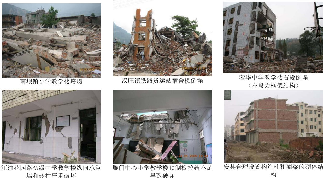
图 2 砖混结构的震害
