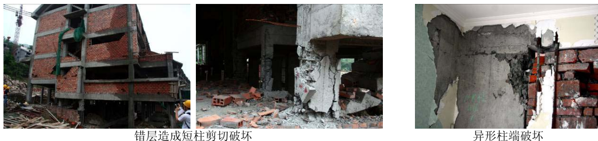
图4 框架结构的震害情况
