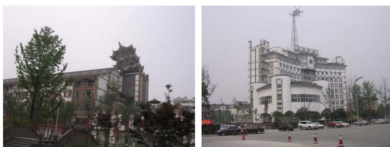
都江堰某公共建筑
