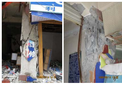
都江堰魁光街底框砖混建筑震害
