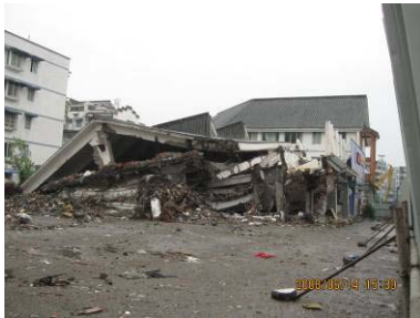
都江堰某住宅小区框架结构倒塌 (屋顶结构太重)
