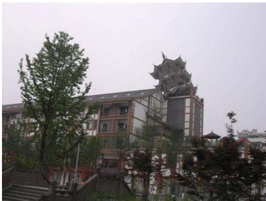
图1 都江堰某建筑顶部出屋面结构破坏
