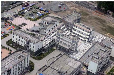
图 1 漩口中学建筑震害示意图(网络照片)
